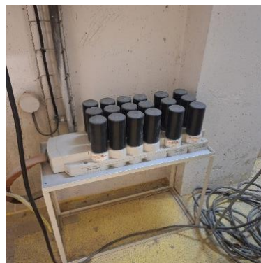
Batterie de condensateurs
